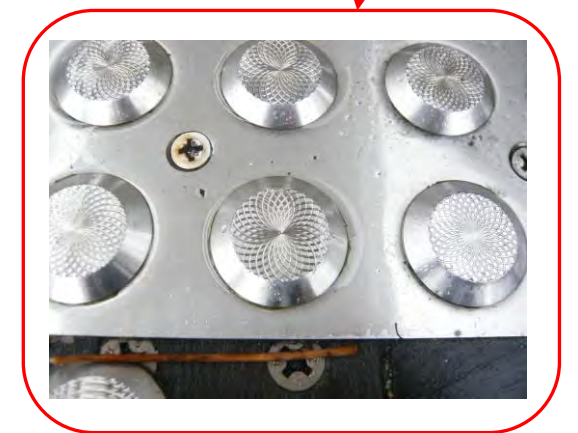
サンポート高松のコリドーで使用されている（一財）安全交通試験研究センター指定福祉協力工場 池田精工(株)製の点字鋇
